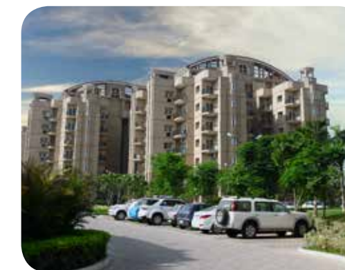
ATS PRELUDE Dera Bassi
